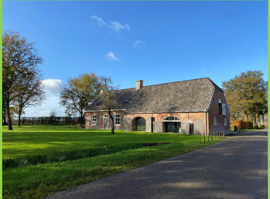
Nieuw pareltje in Markdal. Gerestaureerd geredde monumentale langevelboerderij Notsel
