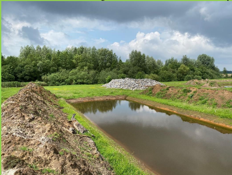
Nu doodlopend. Straks Strijbeekse inlaat voor 'Vrij Stromende Mark'. Ligt klaar voor doorbraak en stortstenen.
