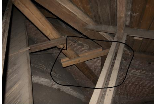
Vervangen balk als onderdeel van de vele dakspanten
