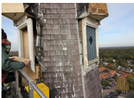
Reparatiewerkzaamheden van de spits
